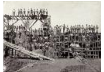
Début de la construction du four de la tuilerie d'Allschwil, 1898, photo: Eduard Muller. © Musée national suisse
